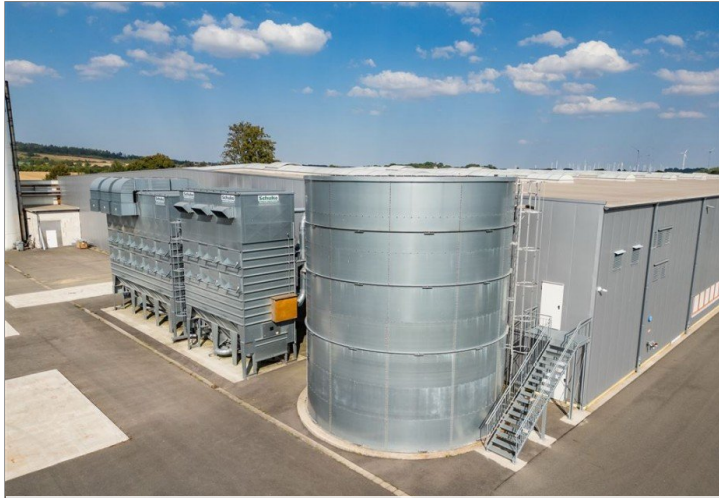
Wassertank Sprinkleranlage
